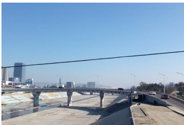
Imagen 2. El puente que divide México y Estados Unidos.
